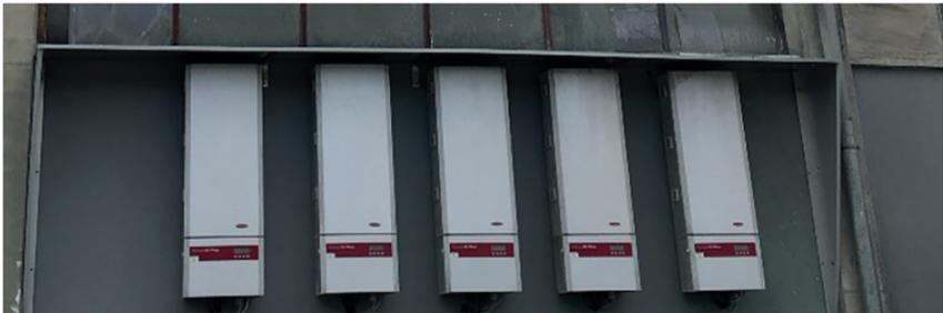
**Bild 2.5** PV-Wechselrichter an der Gebäudeaußenseite mit Überdachung
