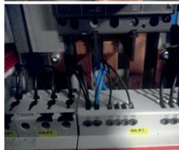
**Die Leiter der Hilfs- und Messstromkreise und des Hauptstromkreises (Stromschiene) sind in nicht geeigneter Weise verlegt, als dass eine Berührung zwischen den basisisolierten Leiter der internen Verdrahtung mit den nicht isolierten Stromschiene des Hauptstromkreises verhindert würde.**
