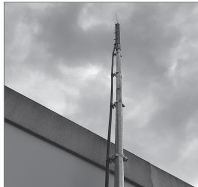
**Bild 11.2** Blitzschutz/Fangeinrichtung an Gas-Druck-Regelanlagen
