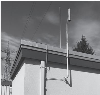
**Bild 11.1** Blitzschutz/Fangeinrichtung an Gas-Druck-Regelanlagen
